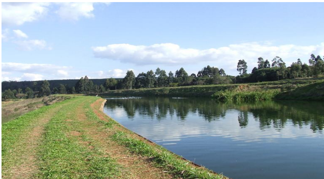
Figura 10 - Lagoa de estabilização da ETE
