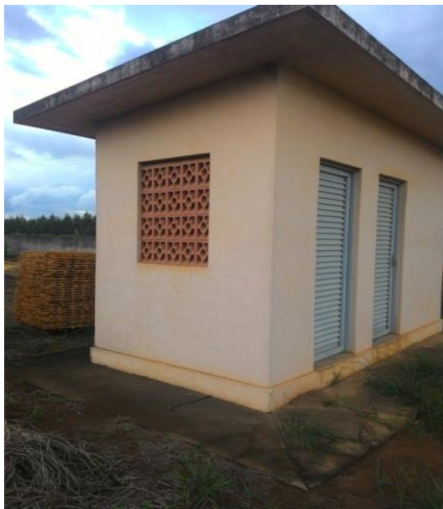
Figura 05 - Casa de Química Distrito Industrial II
