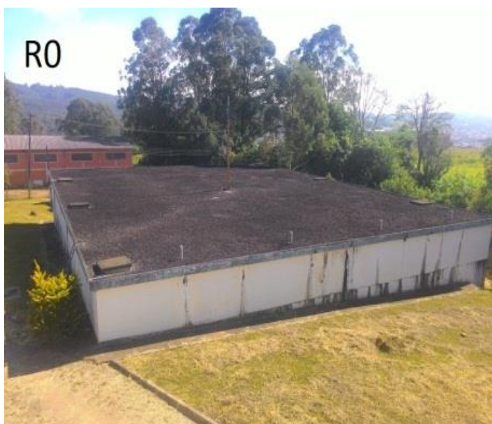
Figura 02 - Reservatório R0 - ETA Matarazzo
