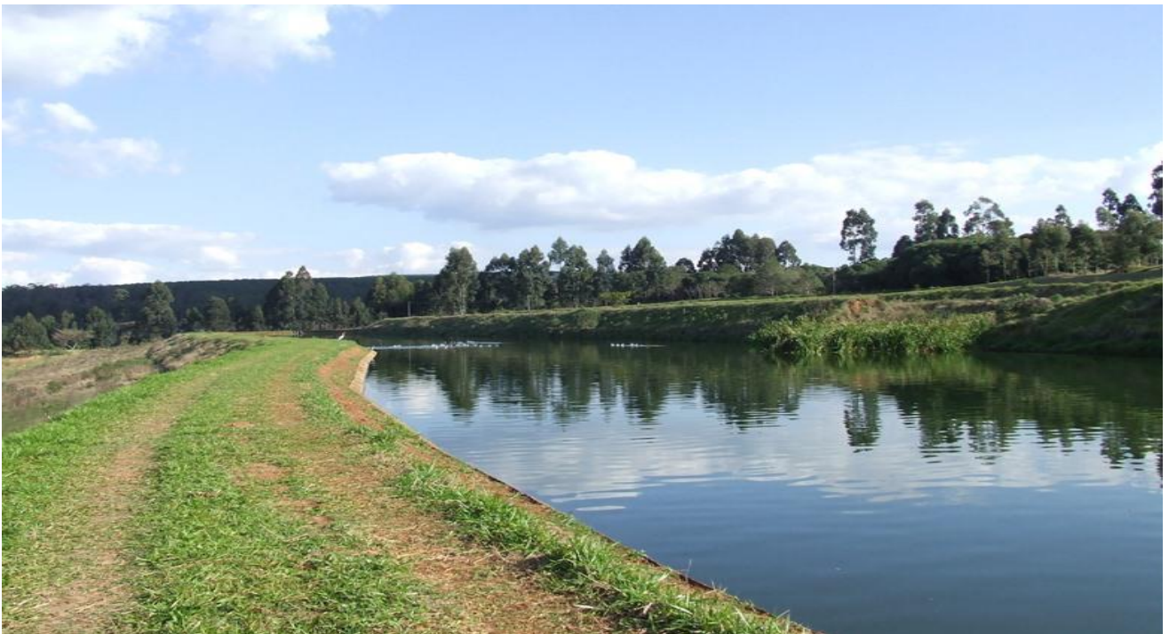
FOTO 02 – Estação de Tratamento de Esgoto (ETE).
