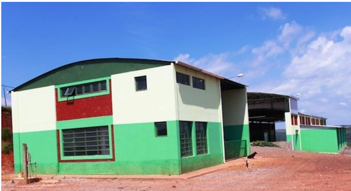
FOTO 06 - Vista externa da Usina de Reciclagem – 02
