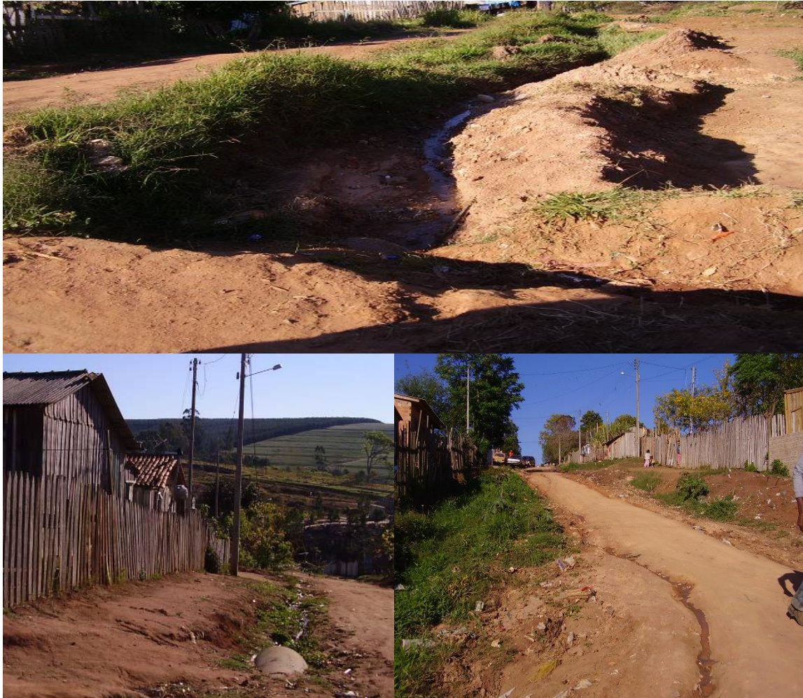
FOTO 03 – Áreas sem galeria de águas pluviais Jardim Primavera.
