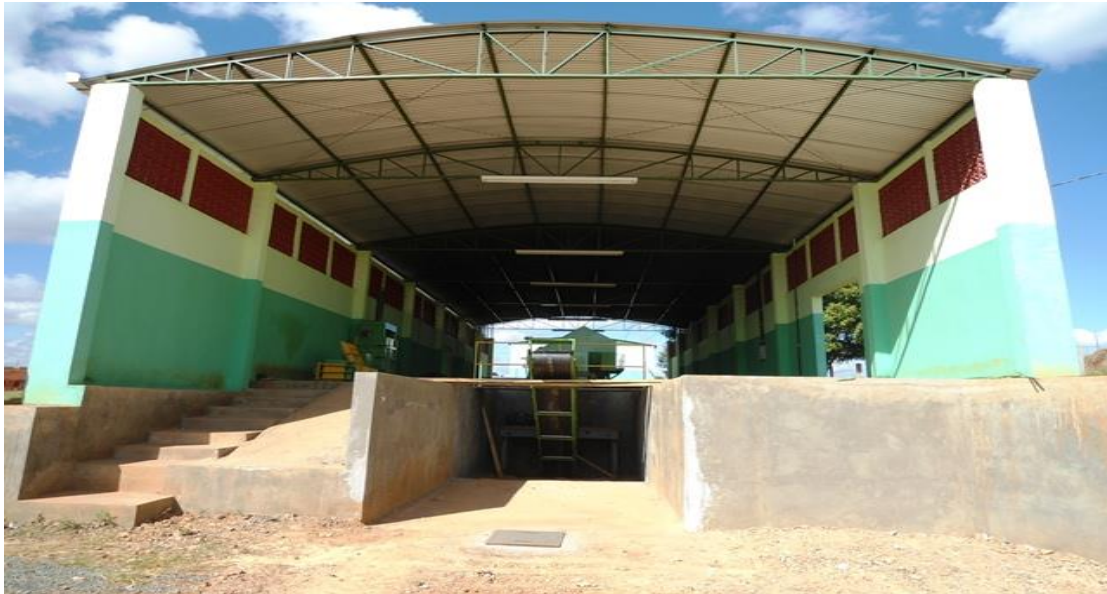
FOTO 05 - Vista externa da Usina de Reciclagem - 01
