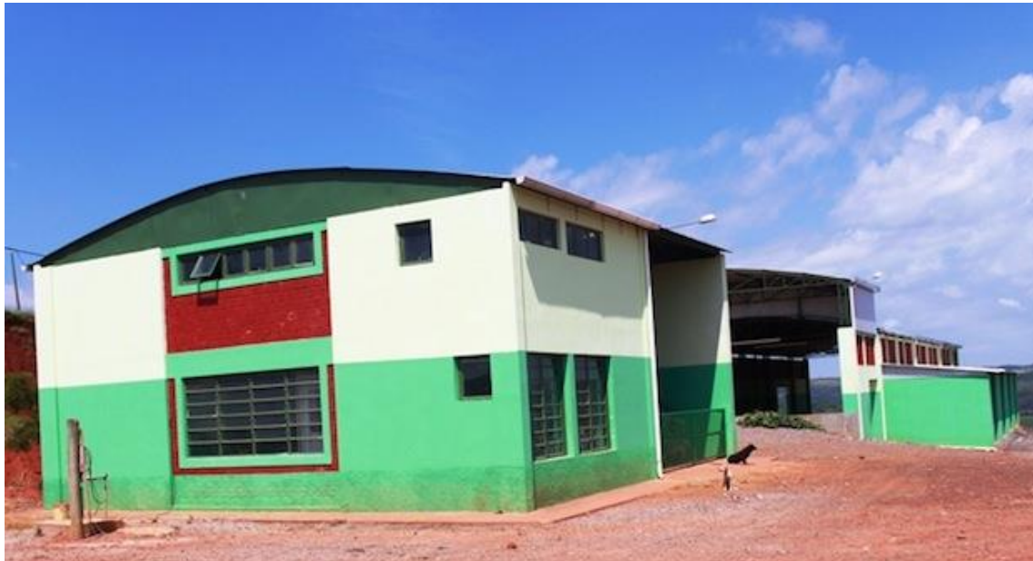
Foto 4 - Vista externa da Usina de Reciclagem – 02
