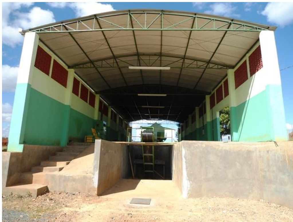
Foto 3 - Vista externa da Usina de Reciclagem - 01
