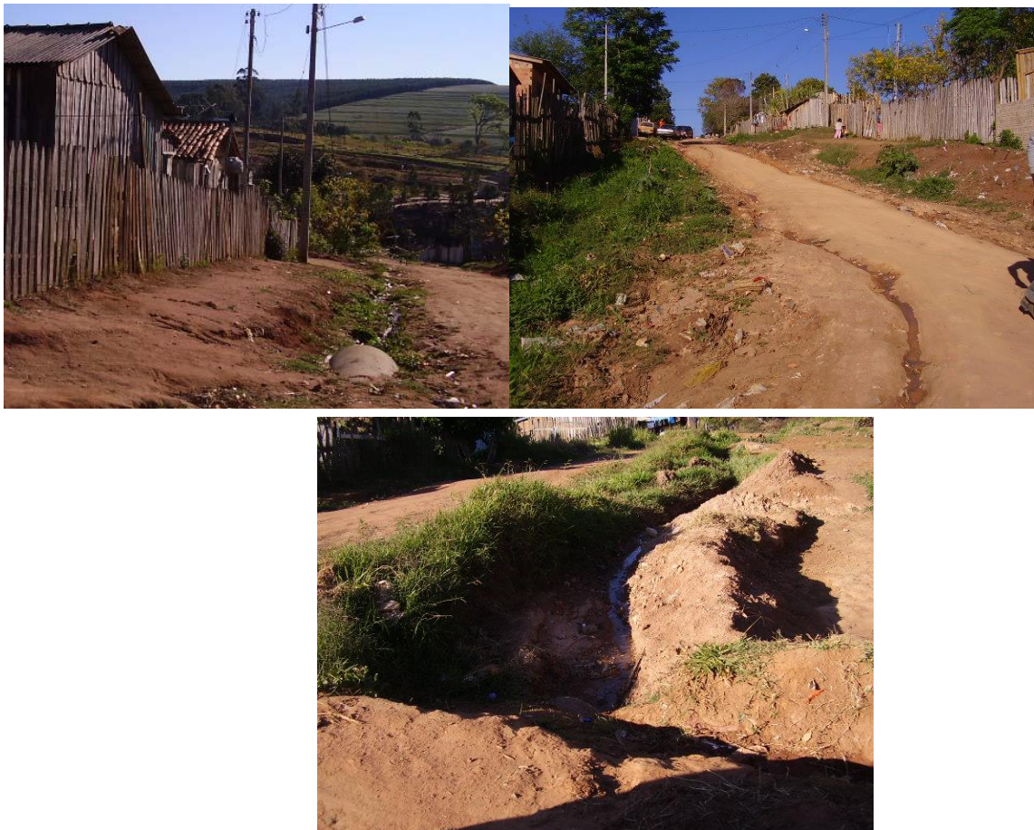
Figura 7 - Áreas sem galeria de águas pluviais Jardim Primavera.
