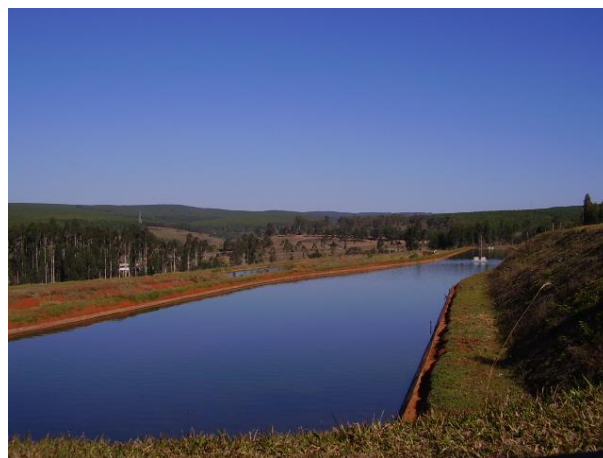
Figura 6 – Estação de Tratamento de Esgoto (ETE).
